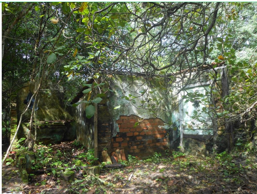
Figura 35: Vista geral da área da Casa Grande antes da limpeza
