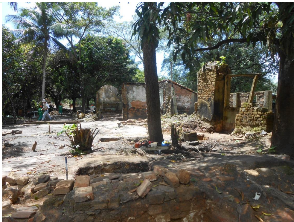
Figura 39: As paredes que restaram da casa grande e as diferentes técnicas construtivas
