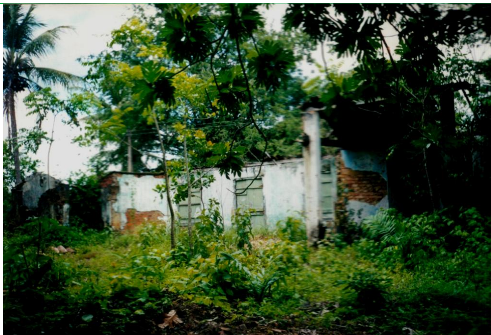
Figura 108: Estruturas do engenho em 2001
