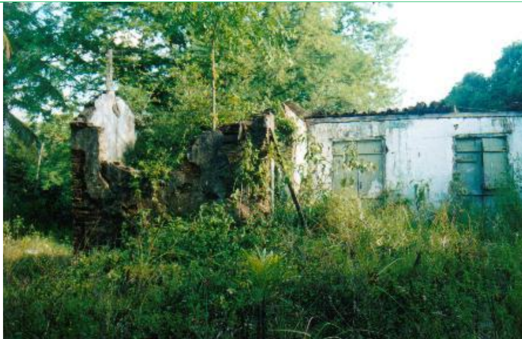
Figura 109: Estruturas da capela da casa grande
