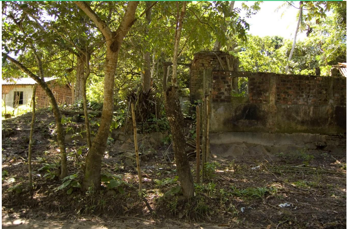
Figura 34: Reformas feitas pelo Sr. Antônio Mauricio faixada externa
